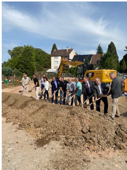
1. Spatenstich für das Objekt Gutleutstraße 4
